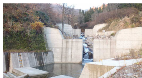
横倉沢第1号砂防堰堤
