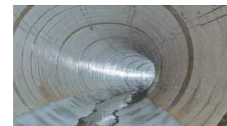
水路トンネル内面補強
