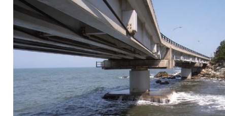
PC桁外ケーブル補強・橋脚部RC巻き立て耐震補強
