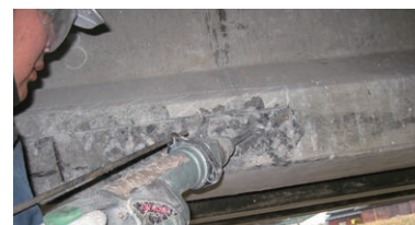
コンクリートはつり調査
