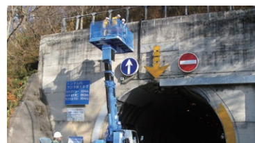
高所作業車を用いた点検
