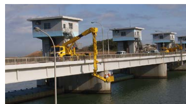
橋梁点検車を用いた点検
