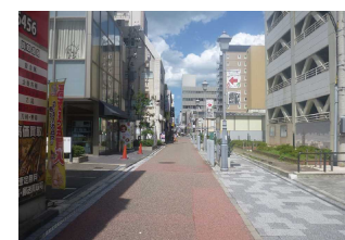
新潟市中央区：版画通り（電線共同溝）
