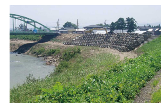
河川復旧：刈谷田川破堤地点
