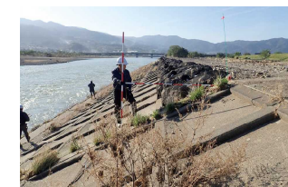
災害調査：千曲川護岸測量
