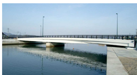
村上市：弁天橋
