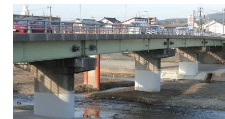
落橋防止設置・橋脚部炭素繊維巻き立て耐震補強
